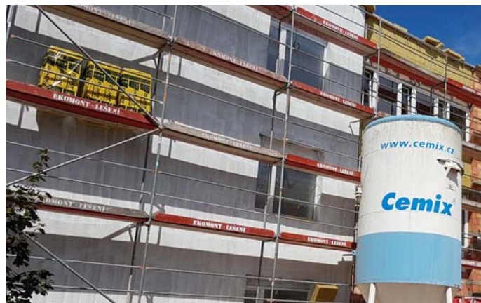
Stavební práce pokračují podle plánu.
